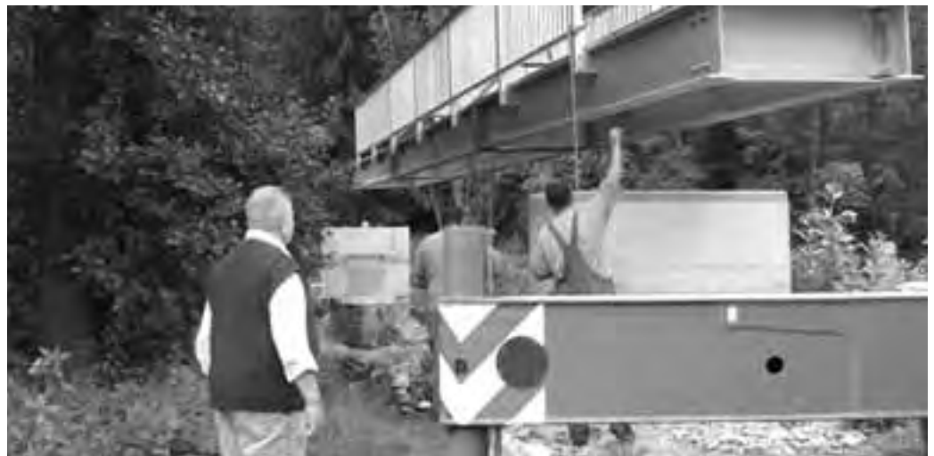
Der Chef persönlich überwacht die Montage des Steges
